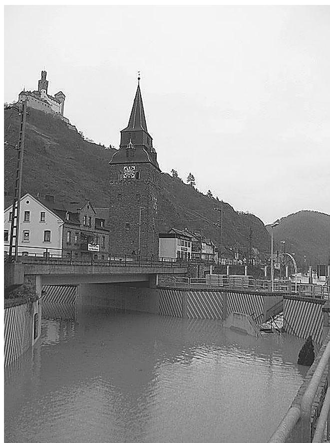
Braubach Hochwasser Januar/Februar 2000, geflutete Trogeinfahrt zur Stadt
